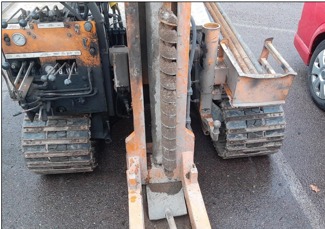
Figur 4. Foto i samband med provtagning av punkt MS02 på parkeringen vid Morängatan (Källa: Deka 2024). Fyllnadsmaterial av grusig sand noteras på skruven.
